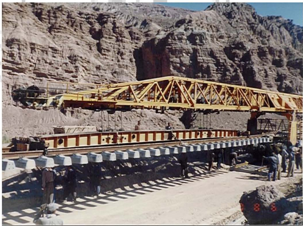
تصویر شماره ۳۹: ماشین نصب خط در حین اجرای عملیات
