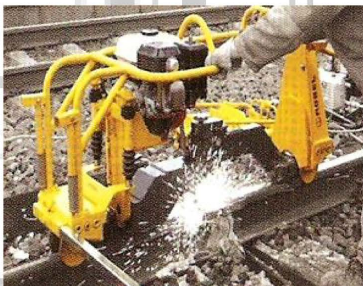
تصویر شماره ۲۴ : دستگاه بغل زنی حین اجرای عملیات براده برداری روی خط
